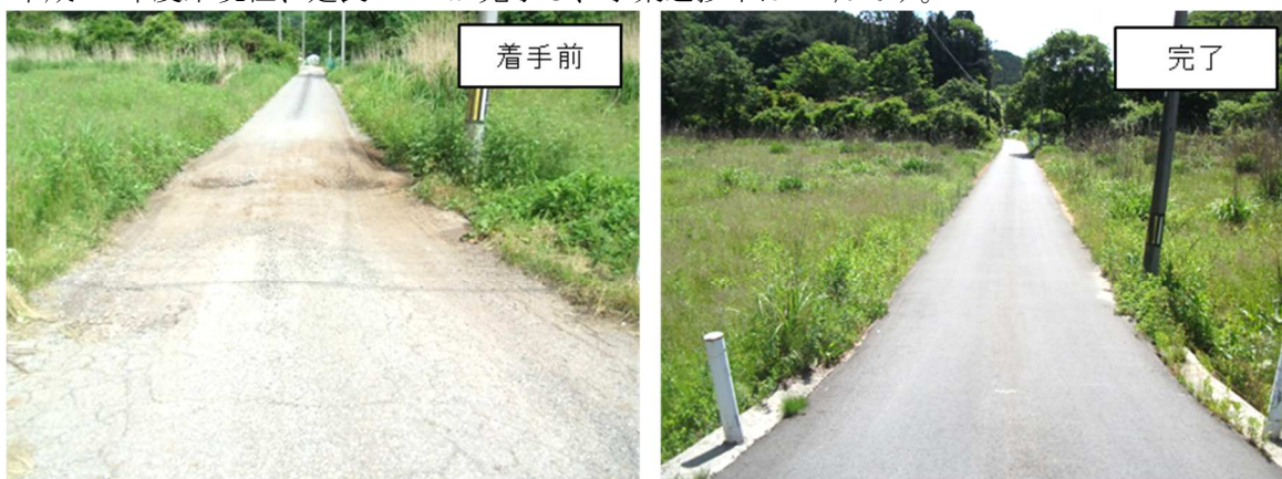
舗装補修工事(農道駒颯線)
