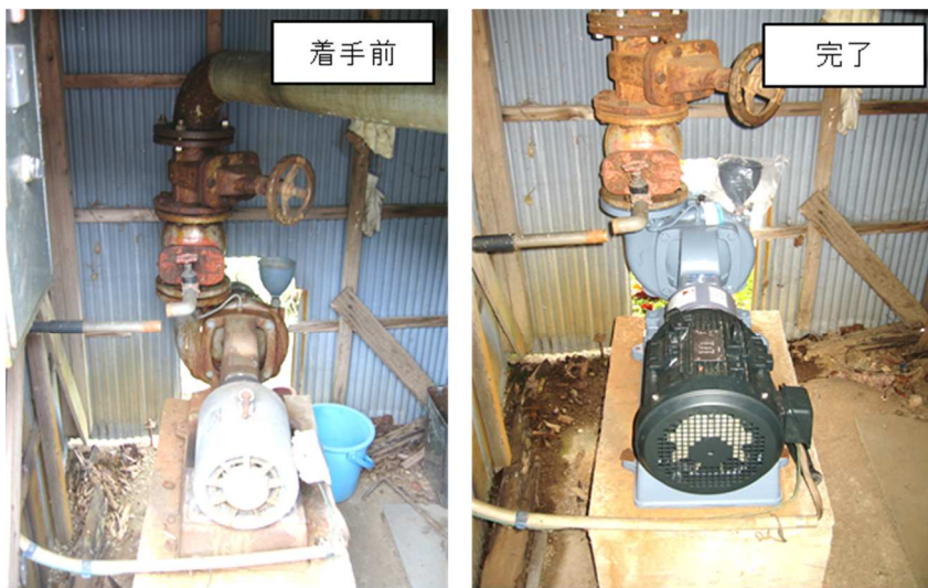
揚水機取替工事(津具下留地区)
