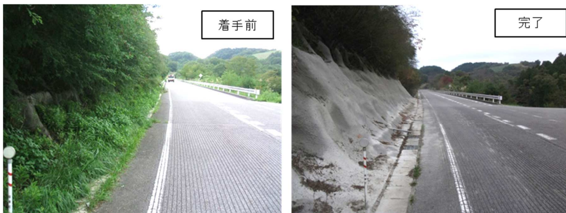
法面改良工事(西納庫地区)
