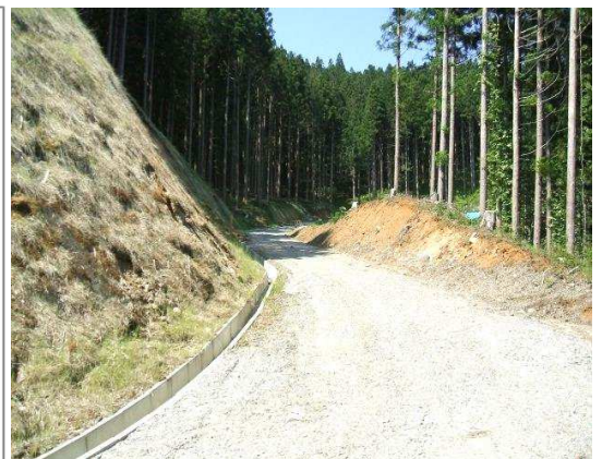
林道白樺支線 開設状況
